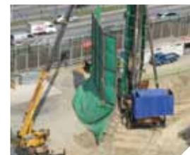
이동식 방음벽 설치
